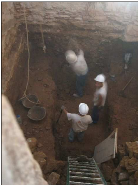
FOTO 35. Peonatge de l'obra excavant a la capella 5, ja amb nivells geològics i amb el vas funerari UE 112 totalment desmuntat
