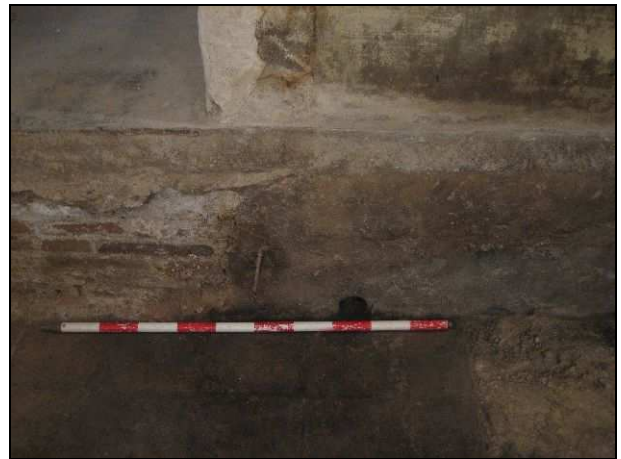
FOTO 8. Detall del desaigüe UE 113 del dipòsit, obert al contrafort que separa les capelles 4 i 5
