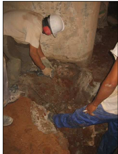
FOTO 36. Aquesta cala va permetre constatar que la fonamentació dels contraforts acabava uns pocs centímetres per sota del nivell de circulació del soterrani (a uns 1,18 m s.n.m.) i que es recolzava sobre el tortorà
