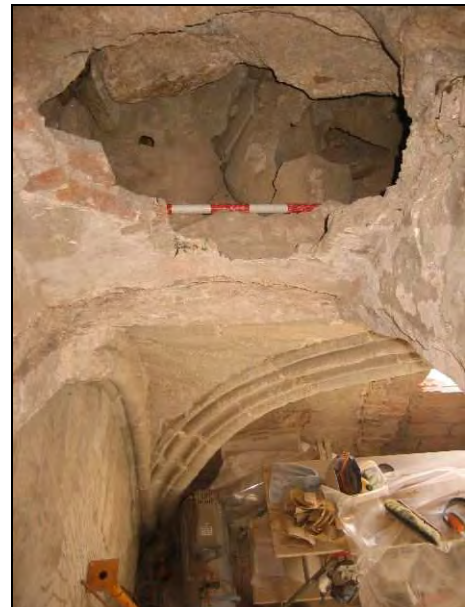
FOTO 32. Vista general de l'interior del carcanyol anterior i part de la volta amb els seus nervis
