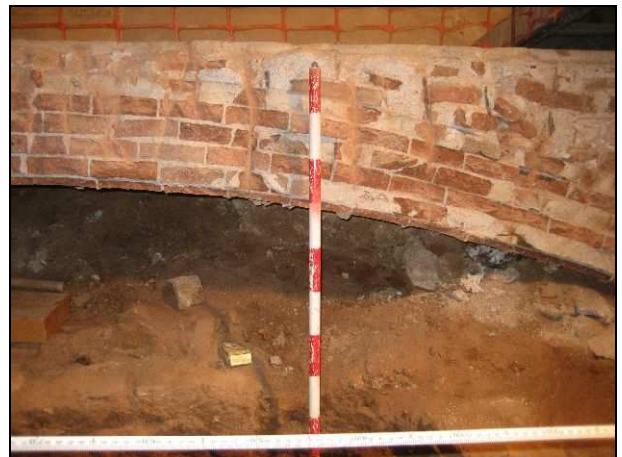
FOTO 12. Vista parcial de la volta UE 114 seccionada
