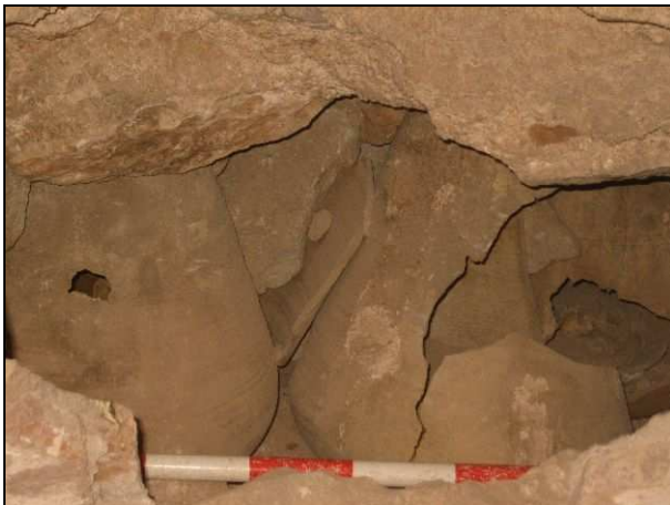
FOTO 31. Detall dels atuells ceràmics utilitzats per omplir el carcanyol de la volta apuntada que cobreix la part superior de la capella 5
