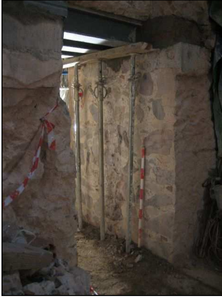
FOTO 33. Detall d'un dels passos oberts entre contraforts a nivell de soterrani. Podem observar la tècnica constructiva dels fonaments amb pedres abocades dins d'una argamassa de morter de calç de qualitat excel·lent. La duresa del material va fer força complicada l'obertura d'aquests passos
