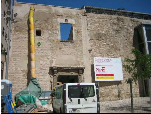
FOTO 1. Vista de l'accés a l'antic claustre del Convent de Sant Agustí des de la plaça de l'Acadèmia
